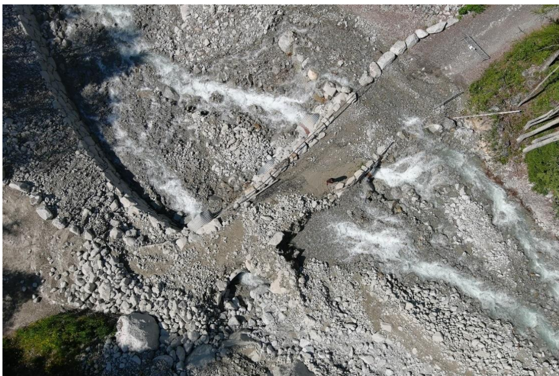
Figura 25: colata detritica sul Torrente Montitaz (2024) in Val Ferret (Courmayeur, AO). Per la valutazione dell'impatto sulle strutture o il censimento dei danni e lo stato delle opere si ricorre a rilievi di dettaglio con UAS multirotori tramite missioni manuali.
