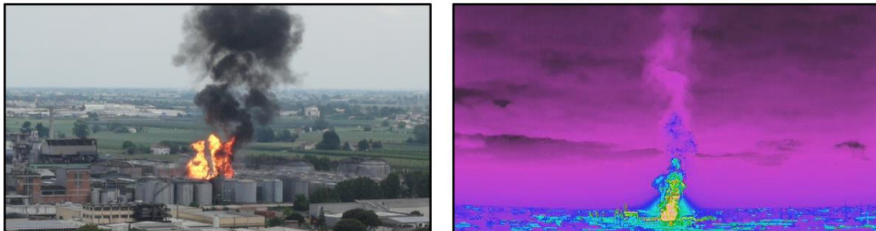
Figura 87: incendio e relativa colonna di aria calda rilevata dalla termocamera in caso di vento aiuta ad individuare la direzione della dispersione di inquinanti.
