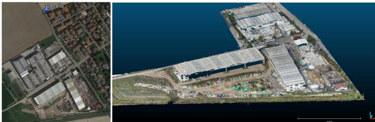
Figura 74: un esempio dei risultati di un rilievo da drone effettuato nell'ambito di un controllo ordinario presso un impianto di trattamento di rifiuti: la tecnica fotogrammetrica ha consentito l'individuazione e la stima accurata della disposizione dei diversi cumuli, ed il loro computo volumetrico.
