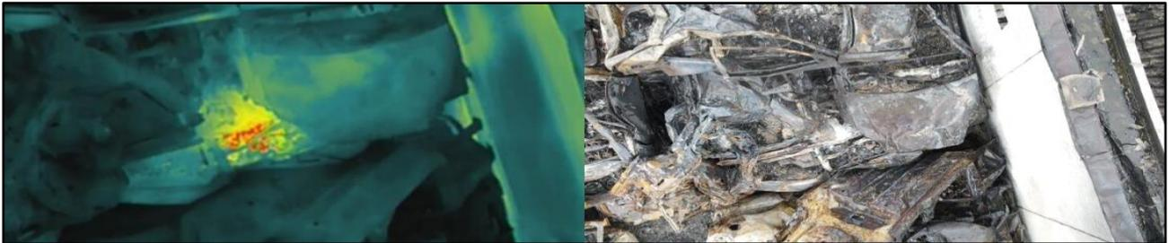
Figura 89: incendio di capannone con copertura di cemento amianto e successiva fase di incapsulamento/bonifica.
