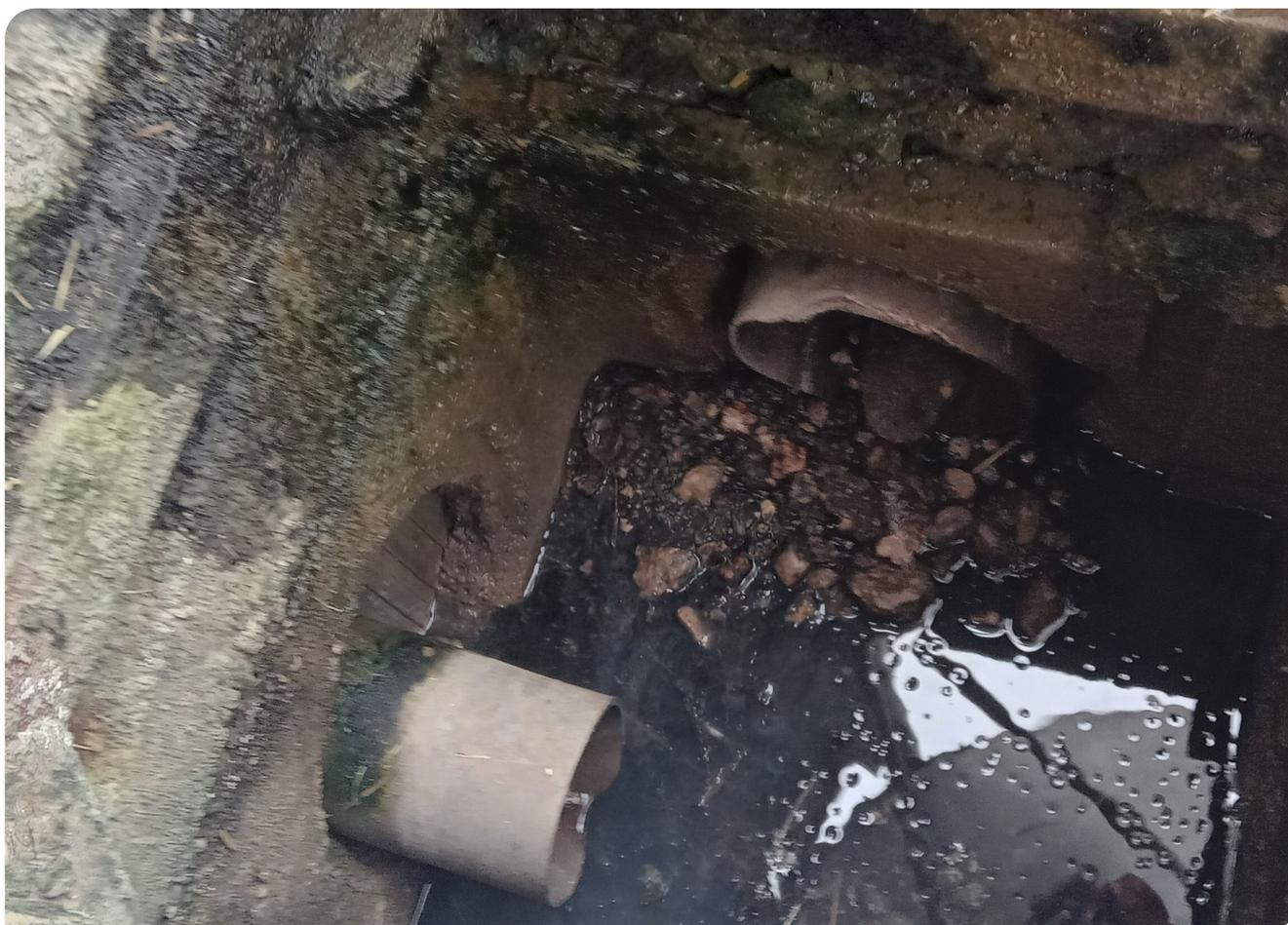
Foto 3 Immissione illecita di effluenti zootecnici nel ricettore mediante tubazione sottotraccia (fonte : Area Territoriale ARPAC Caserta)
