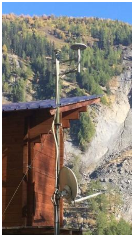
Figura 51 - Esempio di installazione di sistema broadband satellitare (antenna a parabola bidirezionale in basso) per la ridondanza dei dati del sistema di monitoraggio della Frana del Mont de La Saxe (Aosta): Fonte: archivio Attività geologiche – Regione Autonoma Valle d'Aosta
