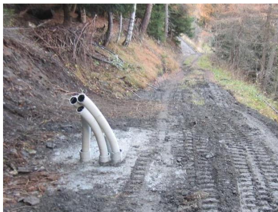
Figura 46 – Esempio di passacavo interrato per ottimizzare alcune installazioni particolarmente complesse. Fonte: archivio Attività geologiche – Regione Autonoma Valle d'Aosta
