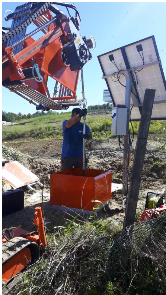
Figura A.35 – Installazione colonna multiparametrica. Fonte: archivio ARPA Piemonte
