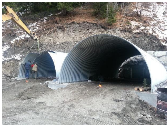
Figura 37 – Realizzazione di un intervento particolarmente importante per la protezione dei sistemi. Fonte: archivio Attività geologiche – Regione Autonoma Valle d'Aosta
