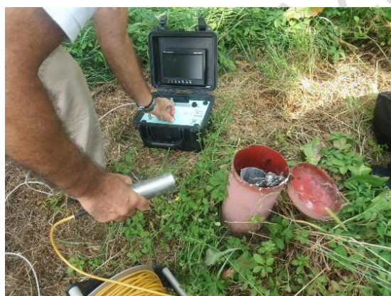
Figura A.30 - Telecamera da foro per l'ispezione del tubo. Fonte: archivio ARPAL
