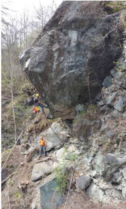
Figura 24 – Operazioni di installazione di una colonna multiparametrica su di un volume roccioso instabile a protezione del cantiere di consolidamento a monte di una strada regionale in Valle d'Aosta (fonte: Regione Valle d'Aosta)
