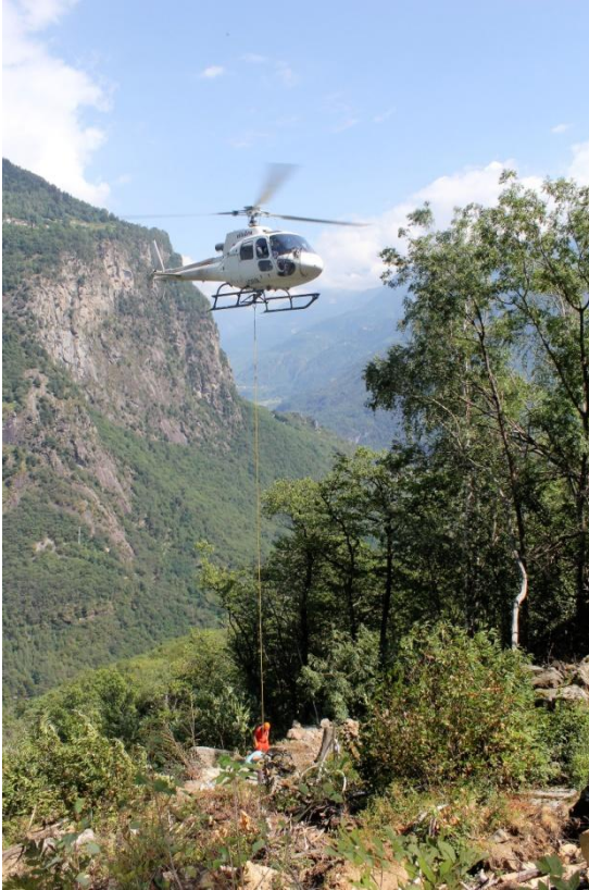
Figura A.35 - Installazione di colonna inclinometrica mediante utilizzo dell'elicottero. Fonte: archivio CMG Arpa Lombardia
