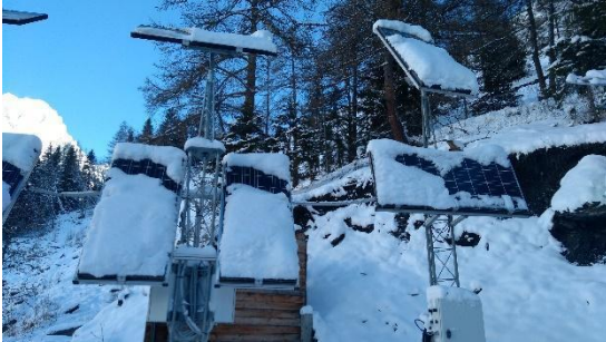
Figura A.52 - Tipico problema di zone di alta montagna, in cui i pannelli possono essere ricoperti di una coltre nevosa che ne impedisce il corretto funzionamento. Fonte: archivio Attività geologiche – Regione Autonoma Valle d'Aosta
