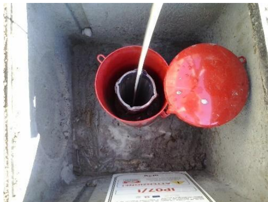
Figura A.28 - Pozzetto di protezione carrabile per testa di tubo inclinometrico. Fonte: archivio ARPAL
