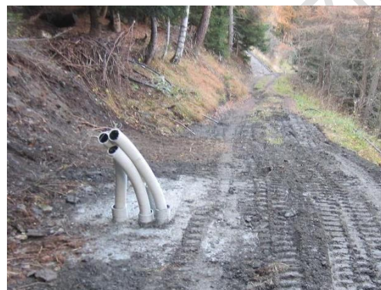
Figura 38 – Esempio di passacavo interrato per ottimizzare alcune installazioni particolarmente complesse. Fonte: archivio Attività geologiche – Regione Autonoma Valle d'Aosta
