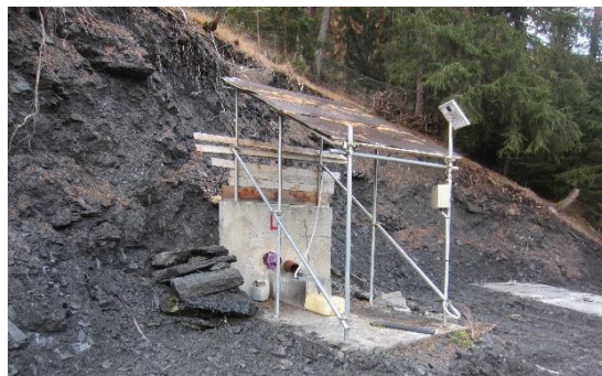
Figura 39 – Fase di costruzione di un monitoraggio idrogeologico, che integra nella platea la parte di cavi e cablaggi. Fonte: archivio Attività geologiche – Regione Autonoma Valle d'Aosta
