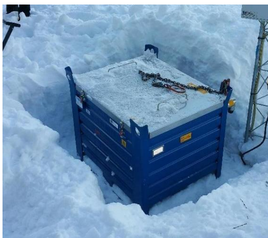
Figura A.54 - Installazione pacco batteria per superare la mancanza di insolazione in zone di alta montagna. Fonte: archivio Attività geologiche – Regione Autonoma Valle d'Aosta
