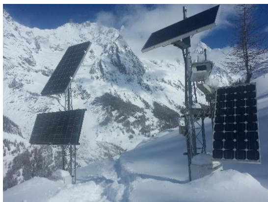
Figura A.51 - Installazione di pannelli fotovoltaici in zona di alta montagna, in cui è presente un notevole carico di neve al suolo. Fonte: archivio Attività geologiche – Regione Autonoma Valle d'Aosta
