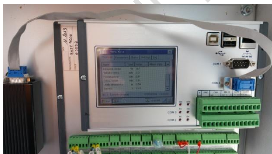
Figura A.49 - Esempio di datalogger con sistema operativo Windows CE, un congruo numero di canali, diverse porte di comunicazione e slot per espansione memoria con SD Card. Fonte: archivio Attività geologiche – Regione Autonoma Valle d'Aosta
