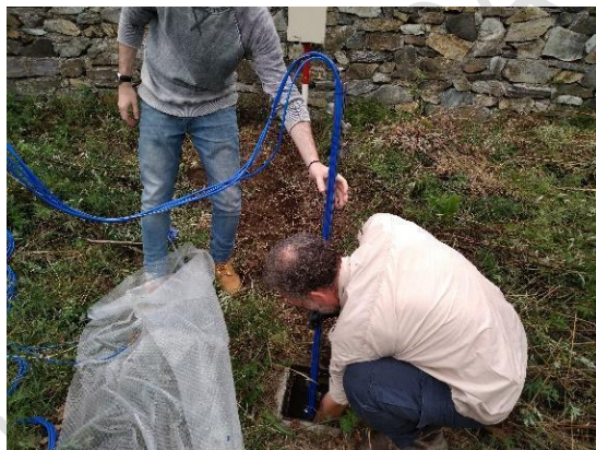
Figura A.33 - Installazione di sonde inclinometriche fisse a profondità identificate dalle campagne di misura inclinometriche manuali. Fonte: archivio ARPAL
