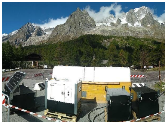
Figura A.55 - Installazione test di un modello di generatore ibrido appositamente costruito, ad alimentazione di un sistema radar interferometrico da terra. Fonte: archivio Attività geologiche – Regione Autonoma Valle d'Aosta
