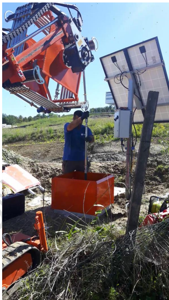
Figura A.34 – Installazione colonna multiparametrica. Fonte: archivio ARPA Piemonte
