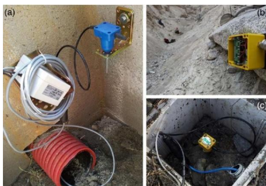
Figura A.22 - Installazione di un geofono (a) sulla parete di un pozzetto in cemento precompresso (Rio Gadria, BZ); (b) su un masso a bordo canale (Chalk Cliffs, CO, USA); (c) nel terreno sulla sponda del torrente (Rio Marderello, TO). Foto: V. Coviello
