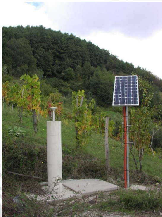
Figura 7 – Monitoraggio in modalità statica con acquisizione in continuo (Frana di Lago, CS). Fonte: archivio GEO-GFI ISPRA
