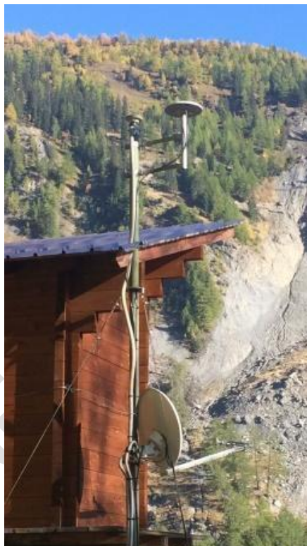
Figura 43 - Esempio di installazione di sistema broadband satellitare (antenna a parabola bidirezionale in basso) per la ridondanza dei dati del sistema di monitoraggio della Frana del Mont de La Saxe (Aosta): Fonte: archivio Attività geologiche – Regione Autonoma Valle d'Aosta
