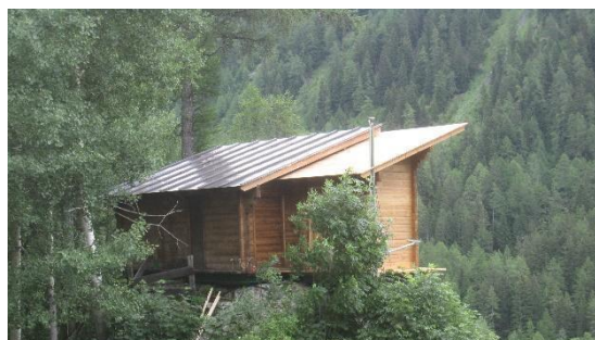
Figura A.57 - Esempio di costruzione in legno per alloggiamento di diverse strumentazioni. Fonte: archivio Attività geologiche – Regione Autonoma Valle d'Aosta
