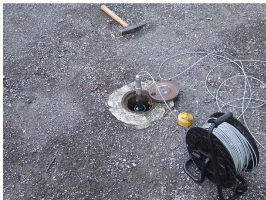
Figura A.29 - Sonda testimone per verifica delle condizioni strutturali della tubazione inclinometrica. Fonte: archivio ARPAL
