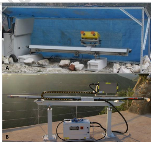
Figura A.15 - Esempi di installazione di sistemi radar ad apertura sintetica (A) su terreno, mediante appoggio su blocchi di calcestruzzo (Fonte: Barla e Antolini, 2016) e (B) mediante montanti ancorati su soletta di cemento (Fonte: archivio Unifi)
