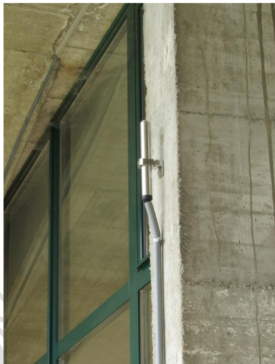
Figura A.6 - Clinometro da parete installato a controllo di un pilastro della palestra comunale di Dossena (BG). Fonte: archivio CMG Arpa Lombardia
