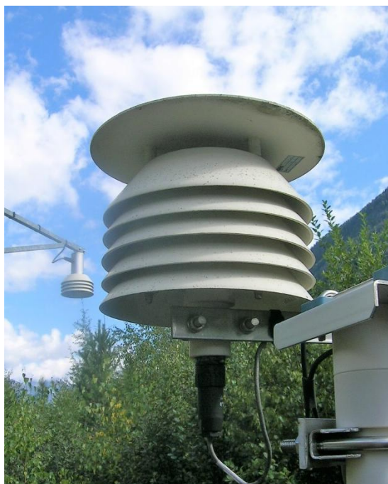
Figura A.47 - Esempio di termometro aria protetto all'interno di capannina antiradiante. Valdisotto (SO). Fonte: archivio CMG Arpa Lombardia
