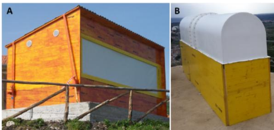
Figura A.16 - Esempi di strutture di protezione della strumentazione. A) casotto con pannello di radome; B) cassone con cupola di radome (Fonte: archivio UniFi)
