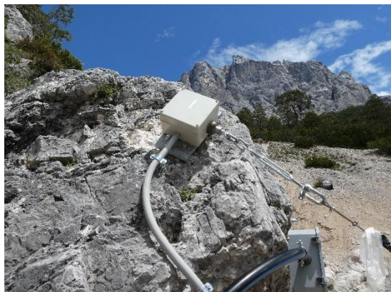
Figura A.23 - Dettaglio dell'installazione di un cavo a strappo: collegamento del cavo all'interruttore sulla sponda in roccia di un canale da colata detritica. Fonte: CNR IRPI
