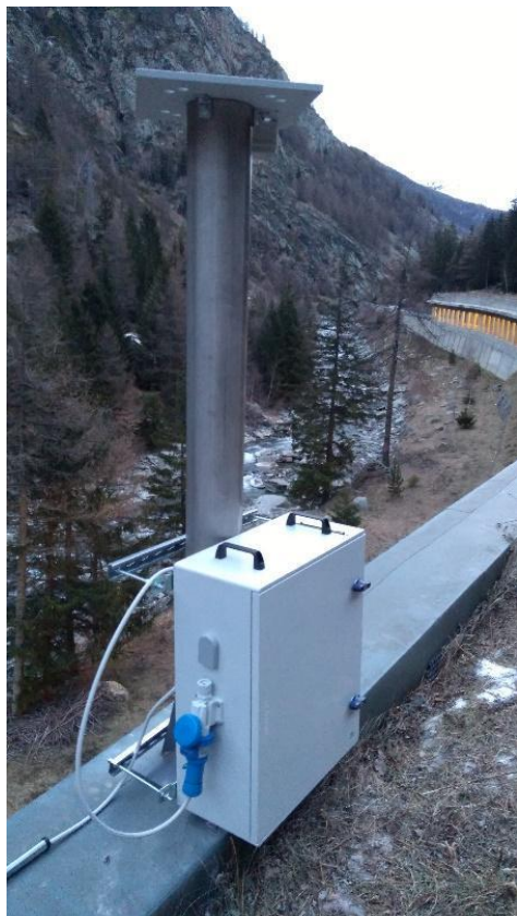
Figura 40 – Alimentazione da rete, con impianto realizzato ad hoc dall'impianto di illuminazione di una galleria su Strada Regionale. Fonte: archivio Attività geologiche – Regione Autonoma Valle d'Aosta
