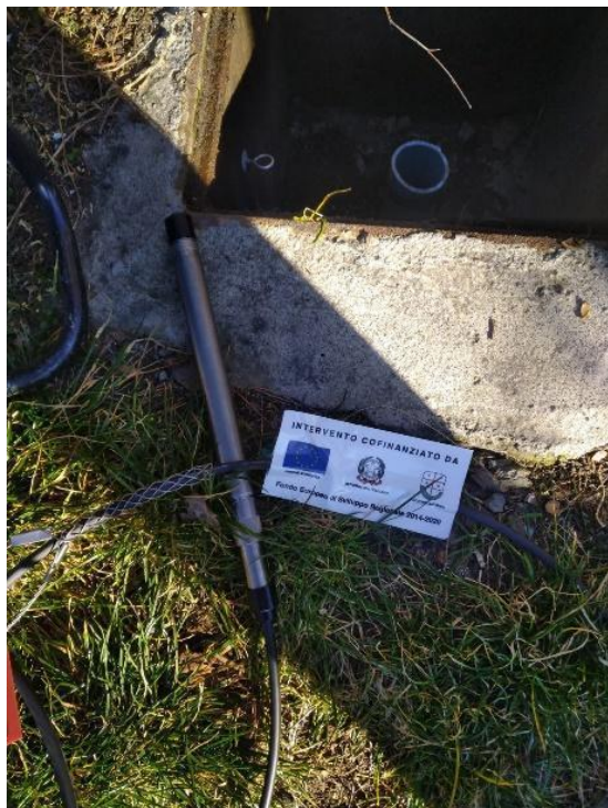
Figura A.42 - Installazione nel piezometro di sonda freaticometrica automatica. Fonte: archivio ARPAL
