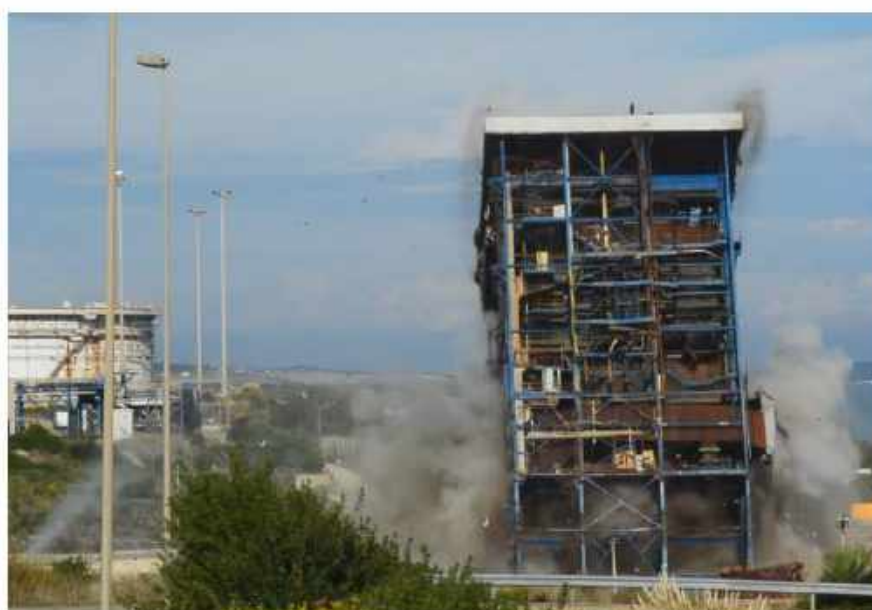
Porto Torres: demolizione controllata delle caldaie della centrale termoelettrica di Fiume Santo
