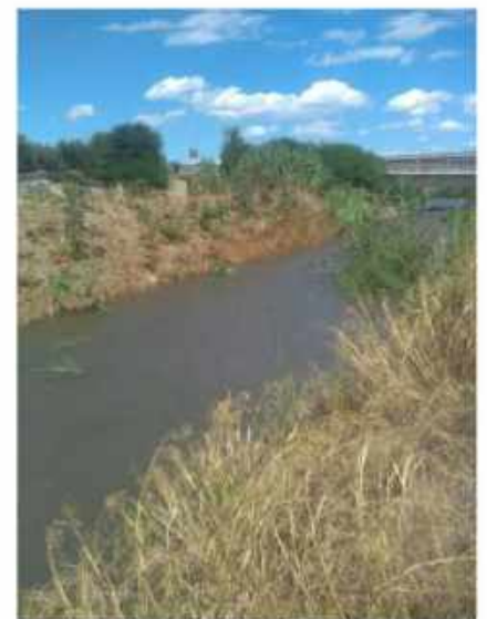
Riu di Sestu a valle del Canale ripartitore SE
