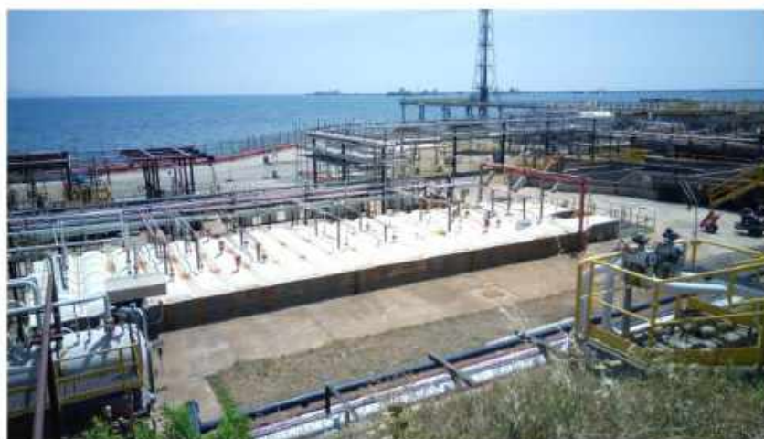
La copertura delle vasche API nell'impianto Versalis di Sarroch
