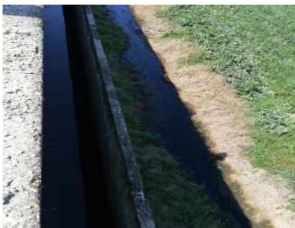
Figura 16. Canale di raccolta del percolato lato nord con il canale di bonifica adiacente
