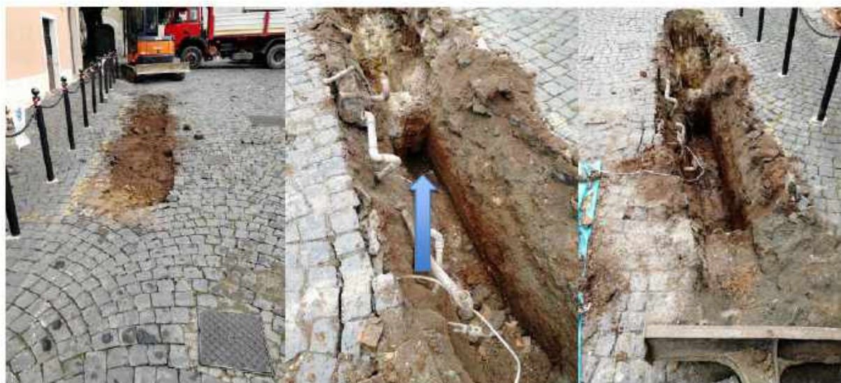
Figura 72. Predisposizione e realizzazione della trincea esplorativa
