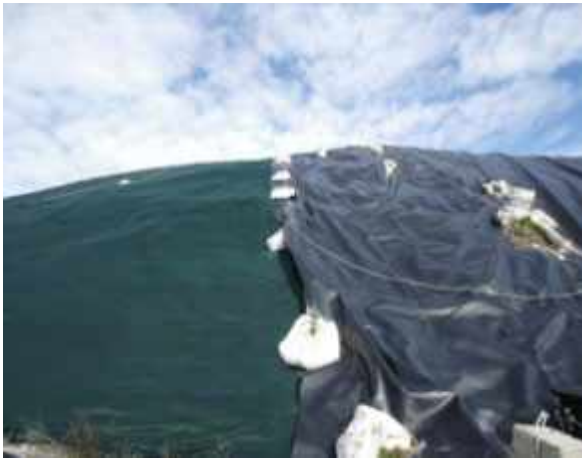
Figura 3. Stato della copertura del corpo rifiuti
