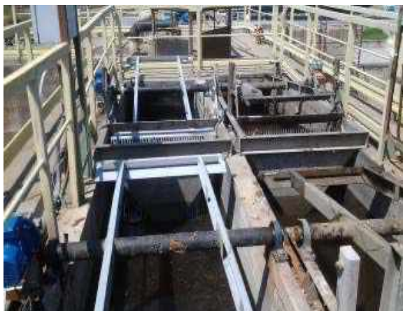
Figura 67. Vasche di grigliatura.
