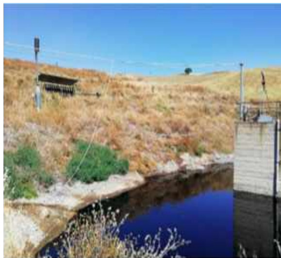
Figura 27. Vista parziale del laghetto con torrino
