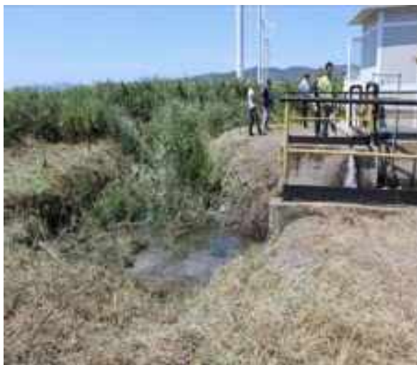
Figura 43. Fossa campereccia presso scarico SF4
