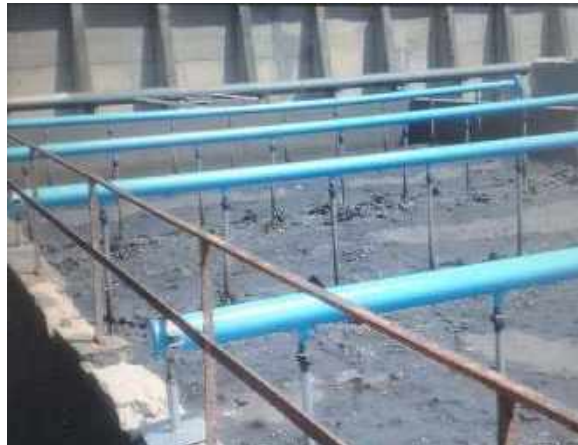
Figura 68. Tubazioni di insufflazione aria ripristinate
