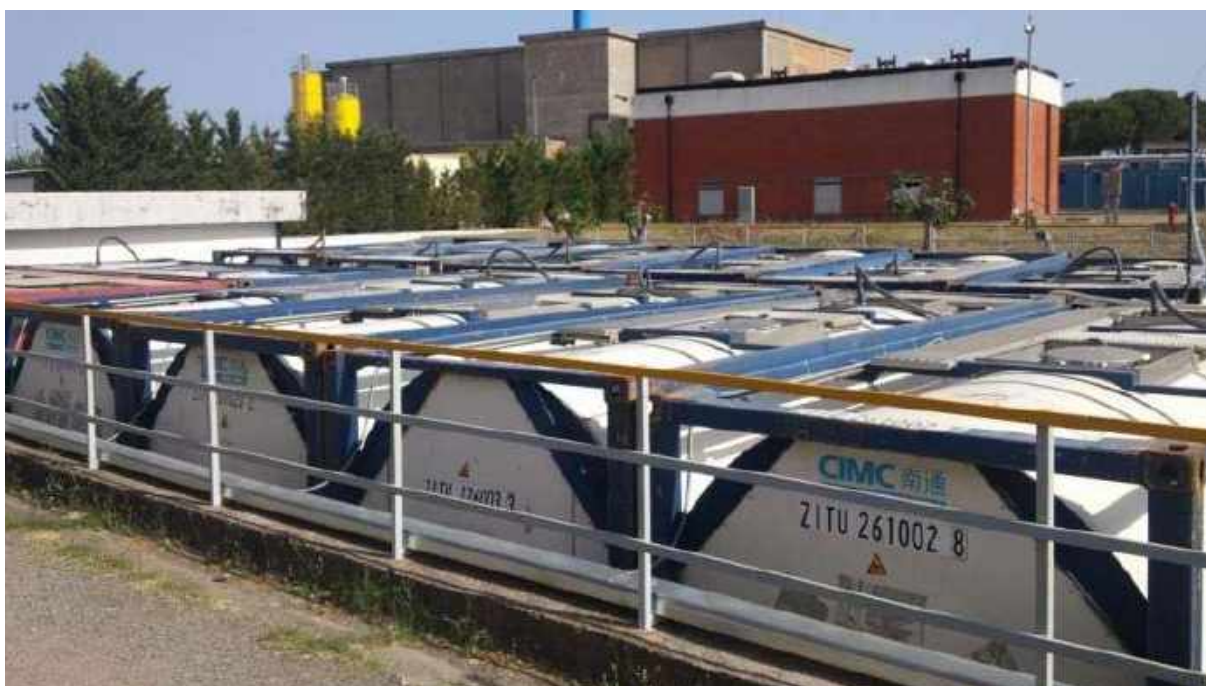
Figura 60. I serbatoi di accumulo in testa all'impianto di trattamento delle acque di falda emunte dai pozzi dell'impianto ITREC.
