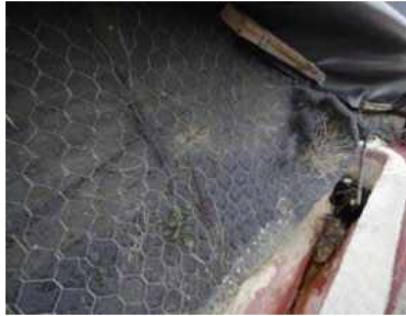
Figura 4. Raccolta del percolato trasudato dalla scarpata
