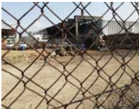
Figura 48. Capannone interessato dall'incendio
