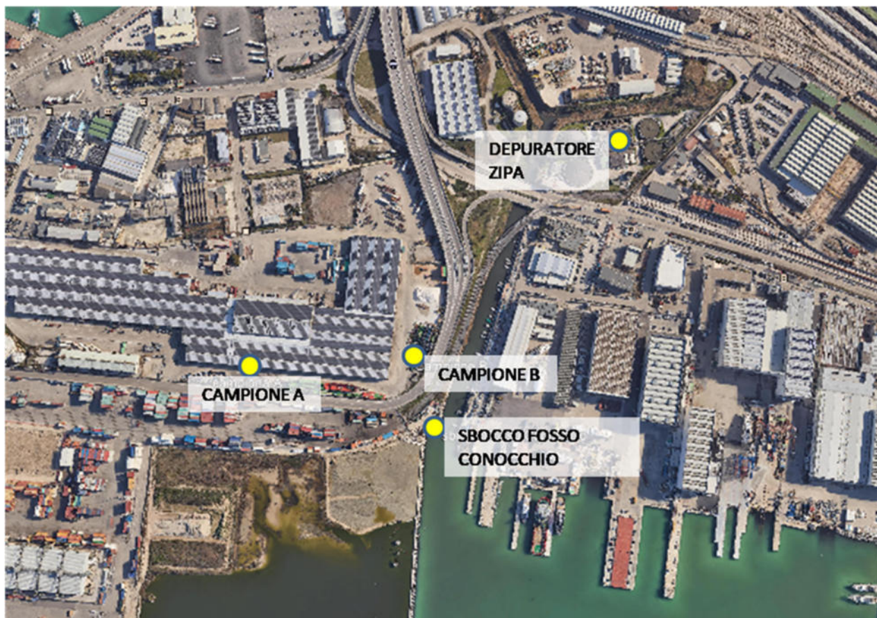
Figura 4 - Localizzazione dei campionamenti delle acque di dilavamento
