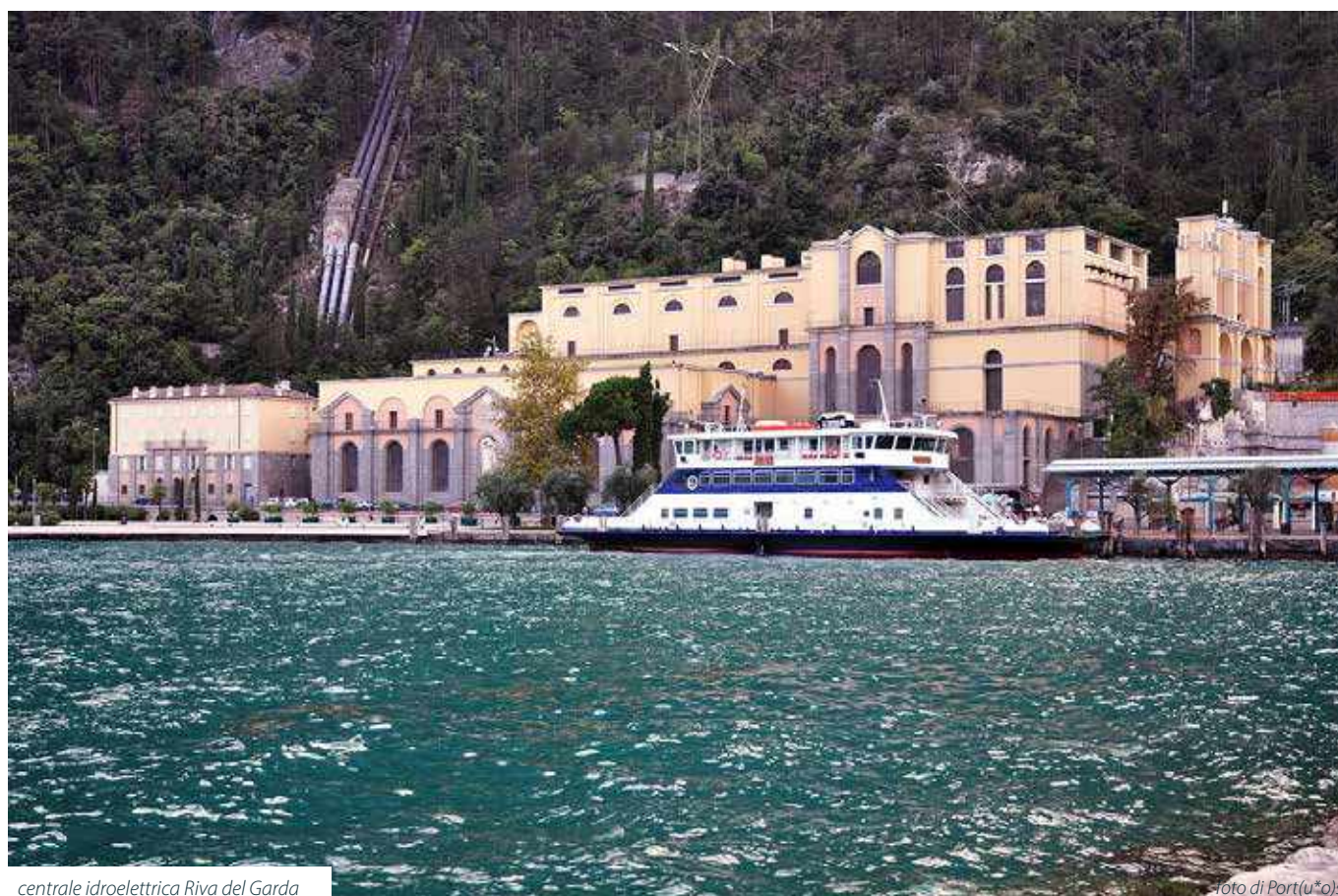
centrale idroelettrica Riva del Garda
