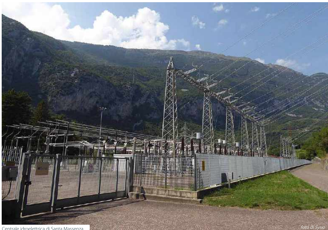
Centrale idroelettrica di Santa Massenza
