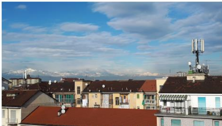
Foto 1 – Impianti Str. Del Fortino 28, 30
