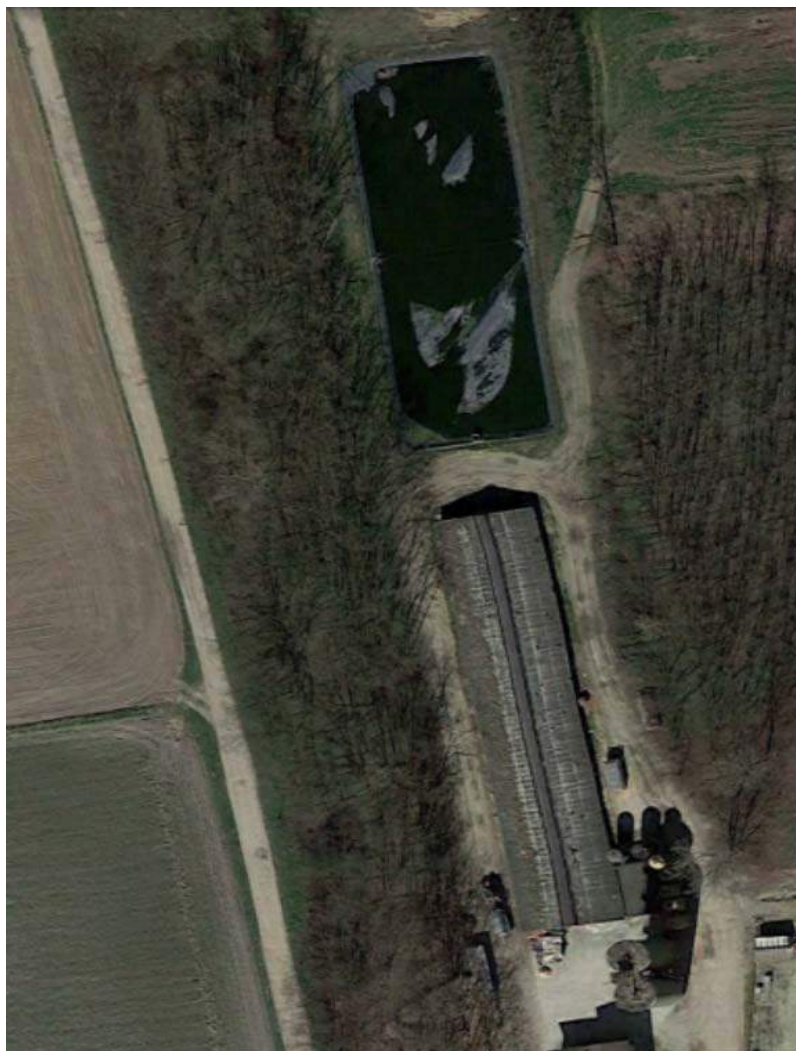
Immagine Google Earth, 10/03/2017. L'impianto zootecnico si presenta con il tetto in presunto cemento-amianto.
