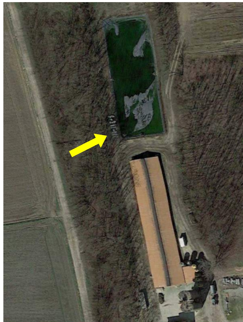
Immagine Google Earth, 23/03/2018, presenza di bancali, si sospetta siano le lastre di cemento-amianto rimosse dall'impianto.
