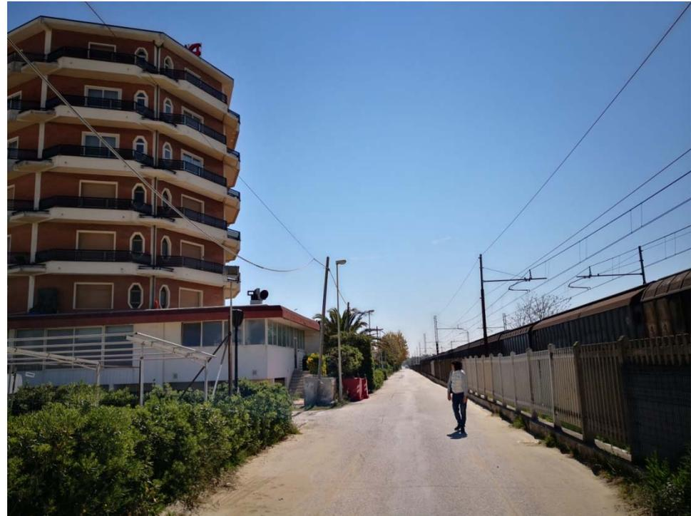
Causa di questo, probabilmente, è la presenza della tettoia al piano terra dell'edificio, che ha schermato parzialmente il percorso del rumore tra la linea ferroviaria ed il microfono posto al 2° piano.
