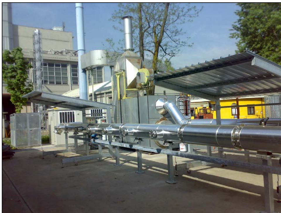
Figura 2 – Impianto LOOP: la sezione predisposta per il campionamento
