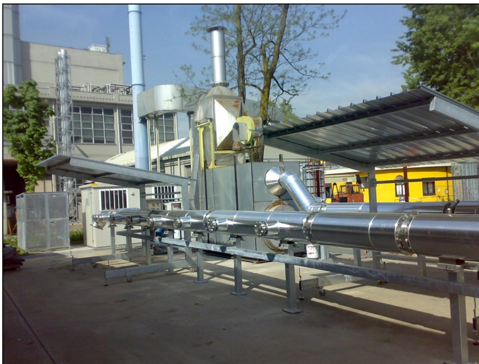
Figura 2 – Impianto LOOP: la sezione predisposta per il campionamento
