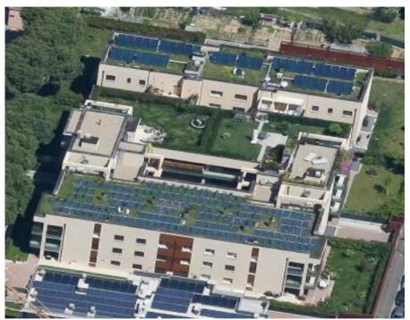
**2015**: edificio residenziale SU 3500 mq, Classe A (23 kWh/mq), Fotovoltaico 50 kW Solare termico 102 mq, caldai a condensazione
